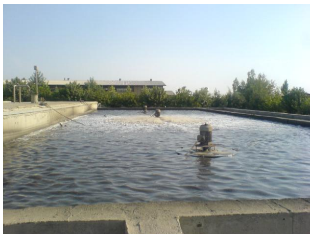
تصویر ۱ - تصفیه خانه شهرک صنعتی بهارستان (کرج)
