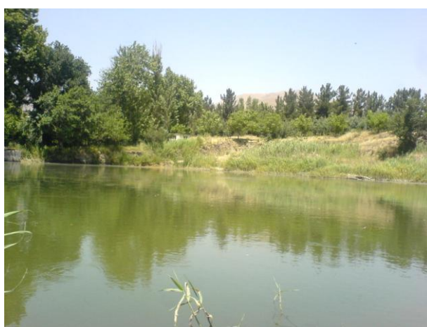
تصویر ۲ - لاگن ۶۰۰۰ متر مربعی جمع آوری پساب بازیافتی بلحجم تقریبی ۱۰۰۰۰ مترمکعب در شهرک صنعتی بهارستان (کرج)
